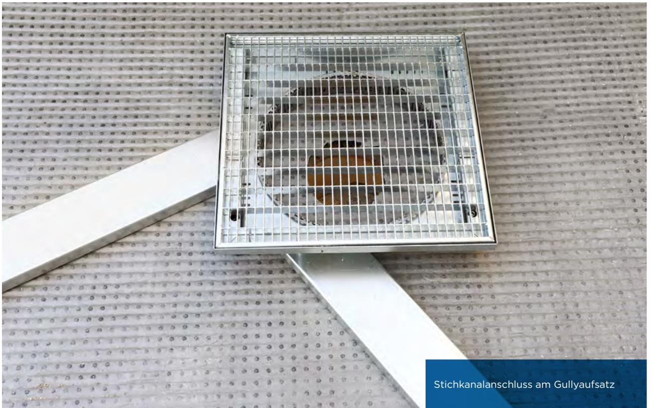
Stichkanalanschluss am Gullyaufsatz
